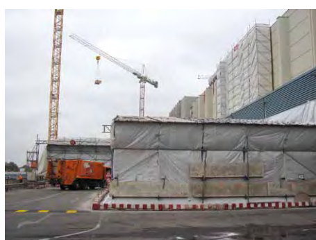
Bild 36: Wetterschutzzelte vom Deck aus gesehen; zu erkennen ist die Beeinträchtigung des Anlieferverkehrs
