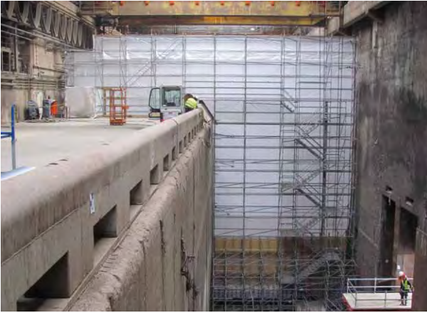
Bild 49 u. 50: Staubschutzwand aus Sicht des Sanierungsbereiches (links) und des Betriebsbereiches (rechts); im unteren Bereich ist die Wand für Abfalldruck ausgelegt, falls auf der Betriebsseite gestapelter Abfall abrutscht, oben besteht die Funktion in der Lufttrennung zwischen beiden Bunkerbereichen; im Vordergrund auf dem linken Bild ist die Einbringplattform für Material vom Anlieferdeck aus erkennbar
