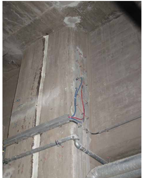
Bild 5: KKS-Probeinstallation an einer Lisene/Stütze des Abfallbunkers mit Stabanoden
