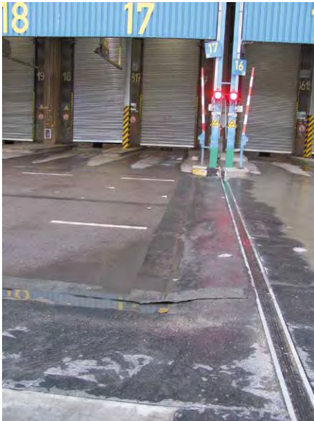
Bild 39: Provisorisch abgedichteter Übergang zwischen saniertem und altem Deckaufbau
