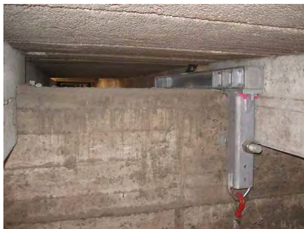
Bild 12 u. 13: Einhängekonsole: Auf dem Kopf liegend und im Einbauzustand mit angehängter Trägerkonstruktion der Gerüstarbeitsplattform
