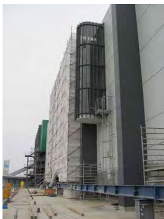
Bild 23: Fassadeengerüst über der Kipphalle mit Brückenträger für Lastabtrag
