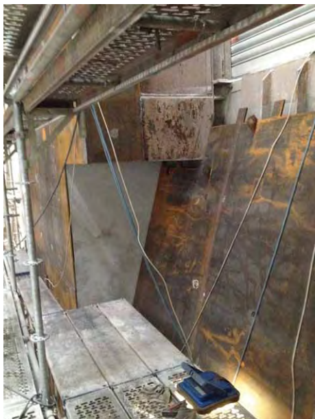
Bild 56 u. 57: Wiedereinbau der 15 mm starken Verschleißbleche durch Lochschweißung auf einbetonierten Ankerplatten
