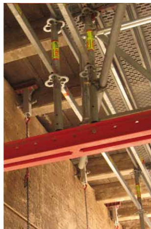
Bild 12 u. 13: Einhängekonsole: Auf dem Kopf liegend und im Einbauzustand mit angehängter Trägerkonstruktion der Gerüstarbeitsplattform
