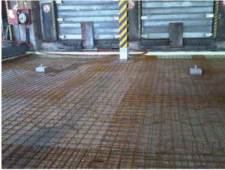
Bild 37: Bewehrungseinbau der Schutzbetonschicht; im Hintergrund: eingebaute Abfalltorverschlüsse
