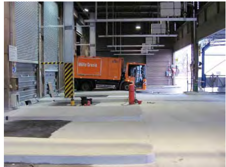
Bild 40: Fast fertiger Bauabschnitt; es fehlt nur noch der Gussasphalt
