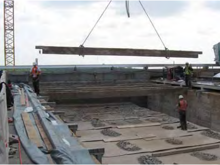
Bild 20: Abbruch der alten Dachhaut; Ausheben einer alten Dachpfetten mit Turmdrehkran
