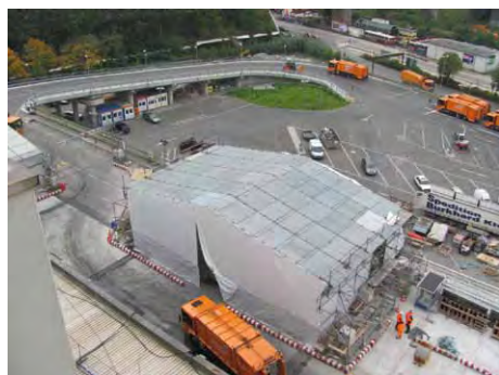
Bild 35: Wetterschutzzelte; Ansicht vom Abfallbunkerdach
