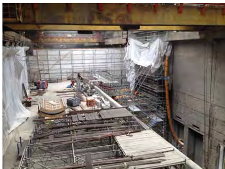
Bild 54: Blick auf die Trichterebene mit rückgebauten Trichtern der ehemaligen Linien 5 bis 8; Nutzung als Logistikfläche im Abfallbunker
