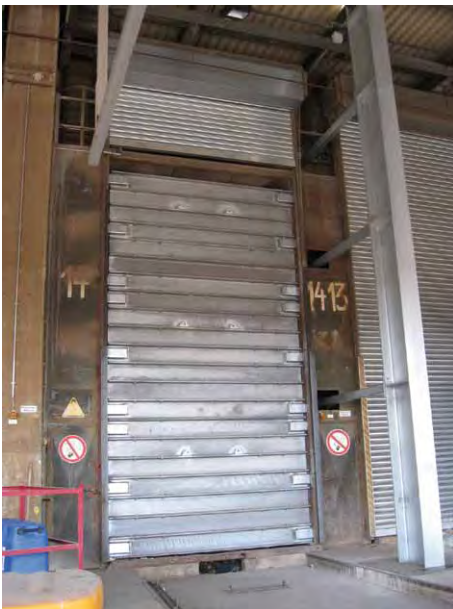
Bild 31: Abfalltorverschluss im eingebauten Zustand
