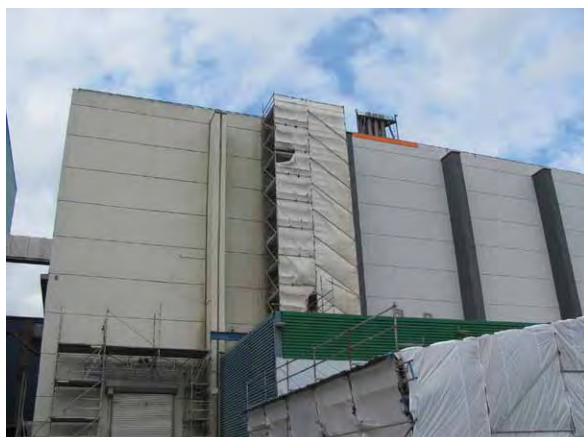
Bild 24: Einrüstung neuer Bauabschnitt (rechts) und fertig sanierter Abschnitt (links); Kipphalle mit teilweise neuem Korrosionsschutzanstrich (grün); im Vordergrund ein Wetterschutzzelt der Sanierung des Anlieferendecks
