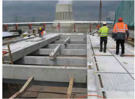
Bild 21: Aufbau der neuen Dachhaut aus Pfetten und Dachplatten mit Aufsatz für neue Lichtkuppeln
