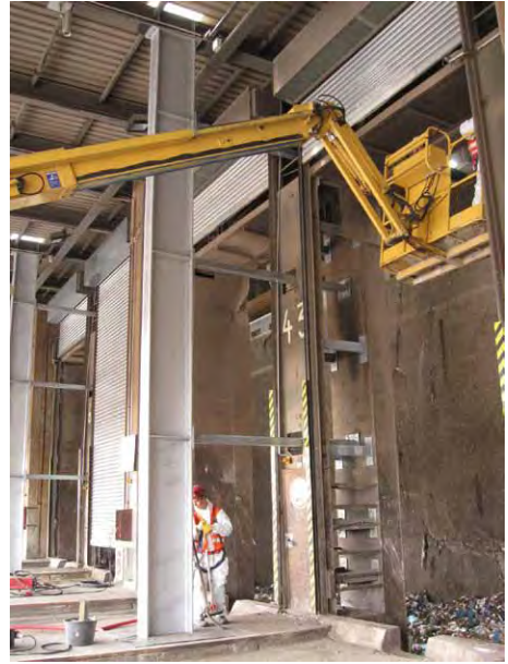
Bild 30: Einbau der Torrahmenverstärkung; Lastabtrag aus den Torrahmen in massive Stahlstützen
